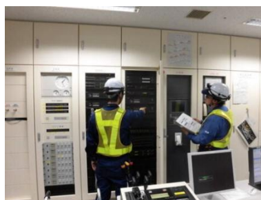
写真1 地下鉄設備点検
